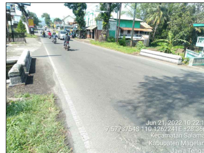
FOTO JALAN PANDANGAN DEPAN JEMBATAN
