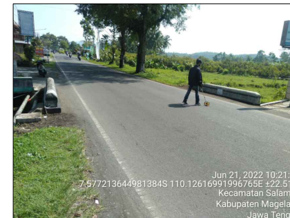
FOTO JALAN PANDANGAN BELAKANG JEMBATAN
