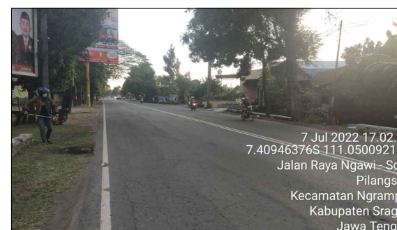
FOTO JALAN PANDANGAN DEPAN GORONG - GORONG
