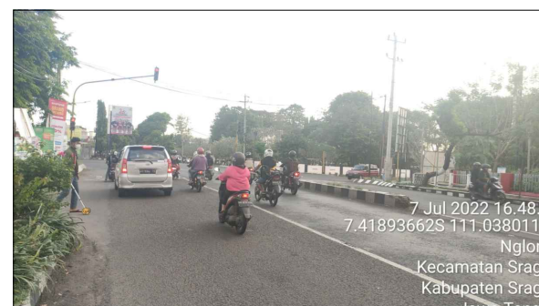
FOTO JALAN PANDANGAN DEPAN GORONG - GORONG
