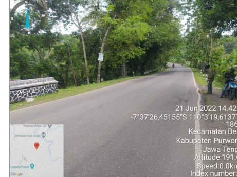
FOTO JALAN PANDANGAN DEPAN GORONG-GORONG
