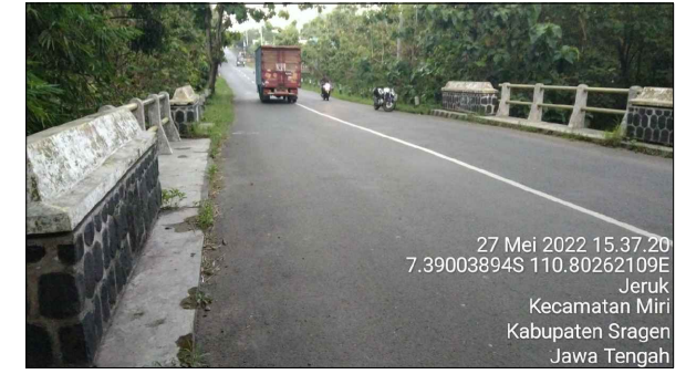
FOTO JALAN PANDANGAN BELAKANG JEMBATAN
