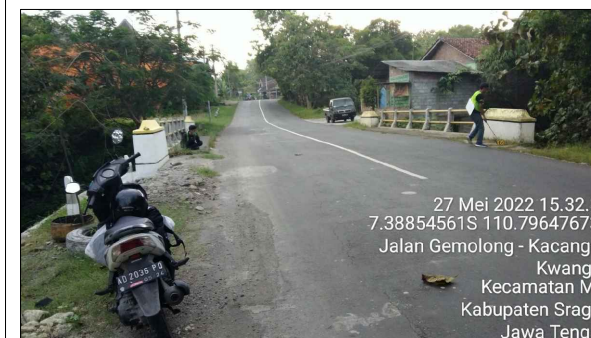
FOTO JALAN PANDANGAN DEPAN JEMBATAN
