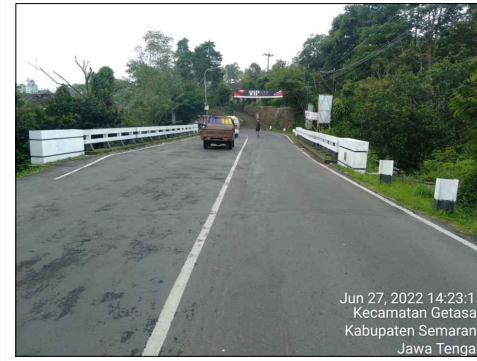
FOTO JALAN PANDANGAN DEPAN JEMBATAN
